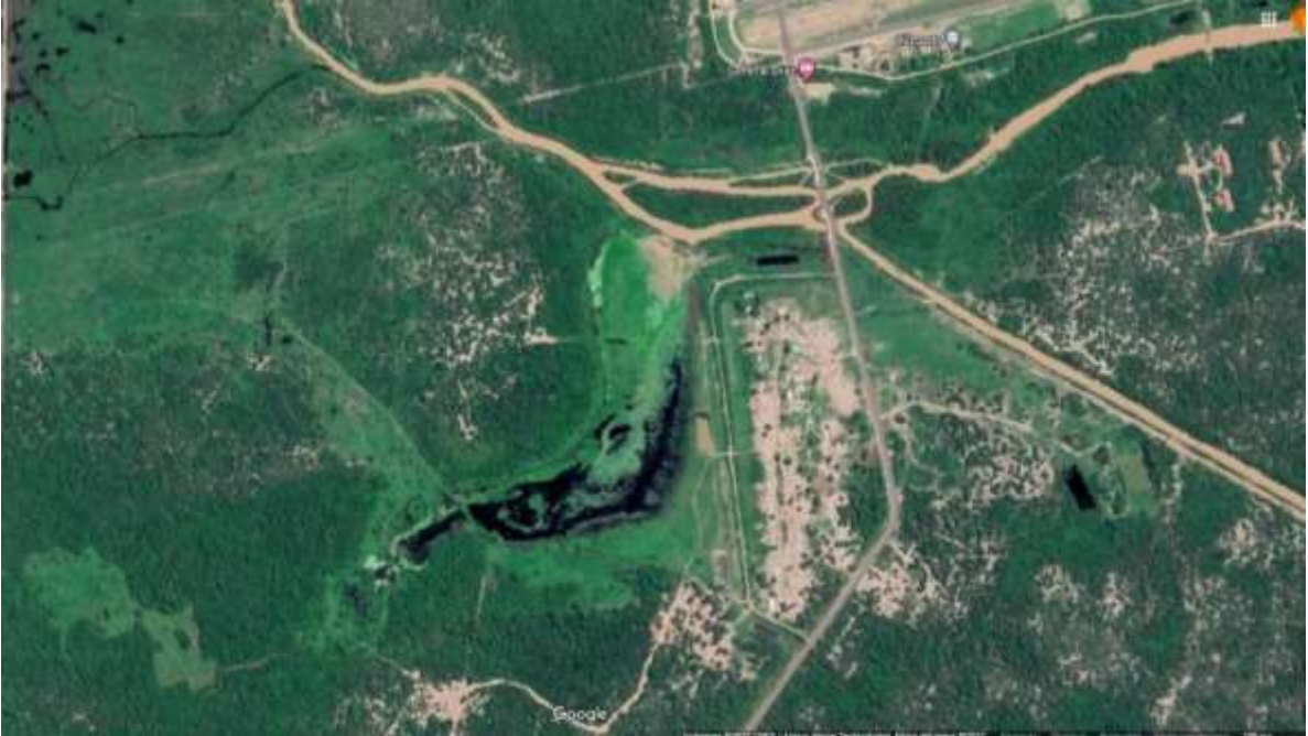
Figura 26 Imagen de Google Maps donde se observa la comunidad de Cacique Sapo, con zonas inundadas, y su relación con el ingreso de ramal del Río Pilcomayo. Así mismo, observamos el muro de contención que evita se inunden
