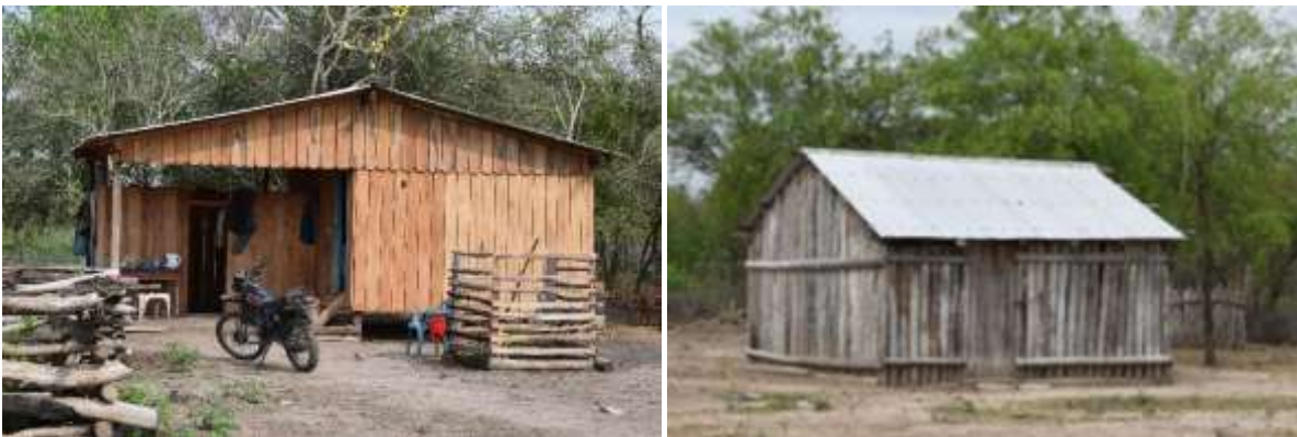
Figura 126 Vivienda construida con recursos del bosque. Hasta hace poco, los techos eran de tejas de Karanday ( Copernicia alba ). hoy eso fue reemplazado por la chapa de zinc.
