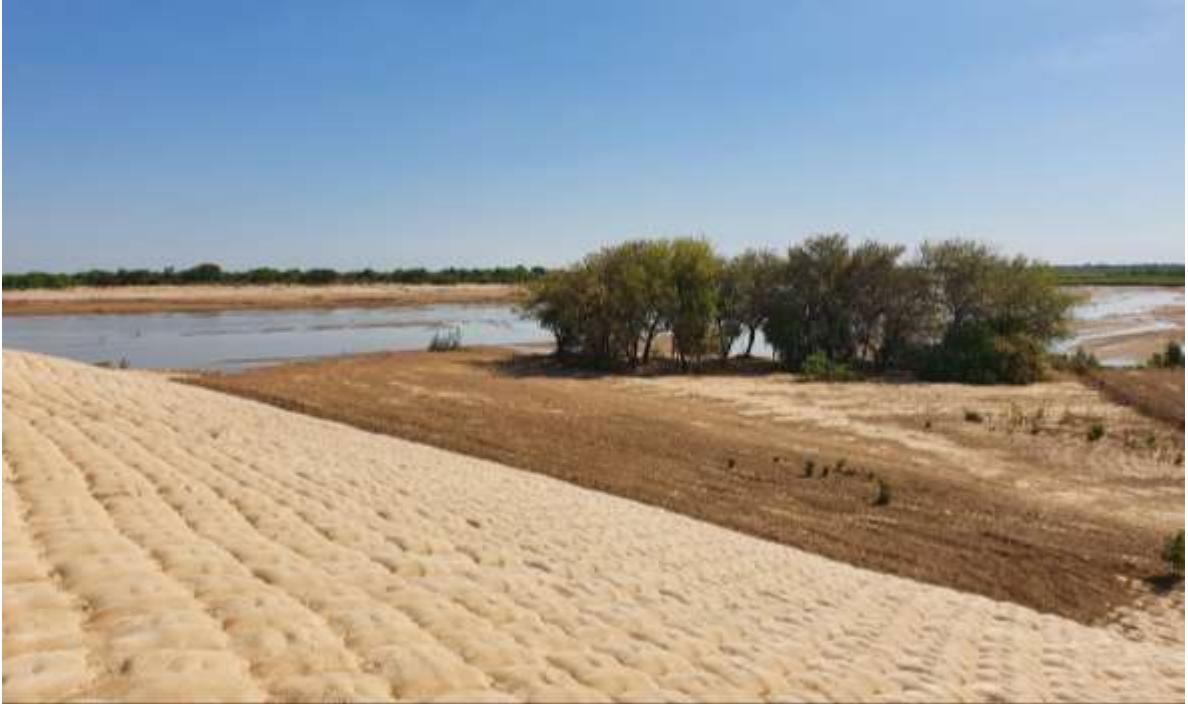
Figura 31 Paisaje donde se observa al fondo el río Pilcomayo, y el muro de contención que protege la ciudad de Pozo Hondo y la comunidad de Jasyendy, de las inundaciones.
