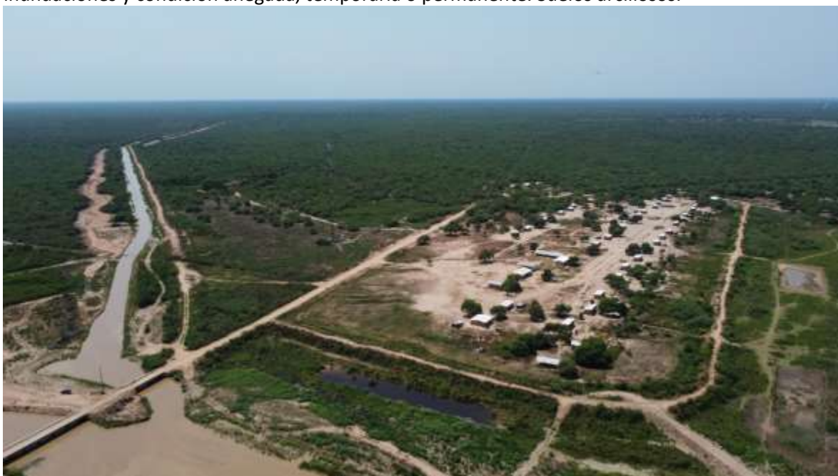
Figura 25 Casco urbano de Cacique Sapo, donde se observa a la derecha el ingreso de las aguas del río Pilcomayo, que en épocas de creciente inunda la comunidad. Este sector está delimitado por un muro de contención, que evita que se inunde
