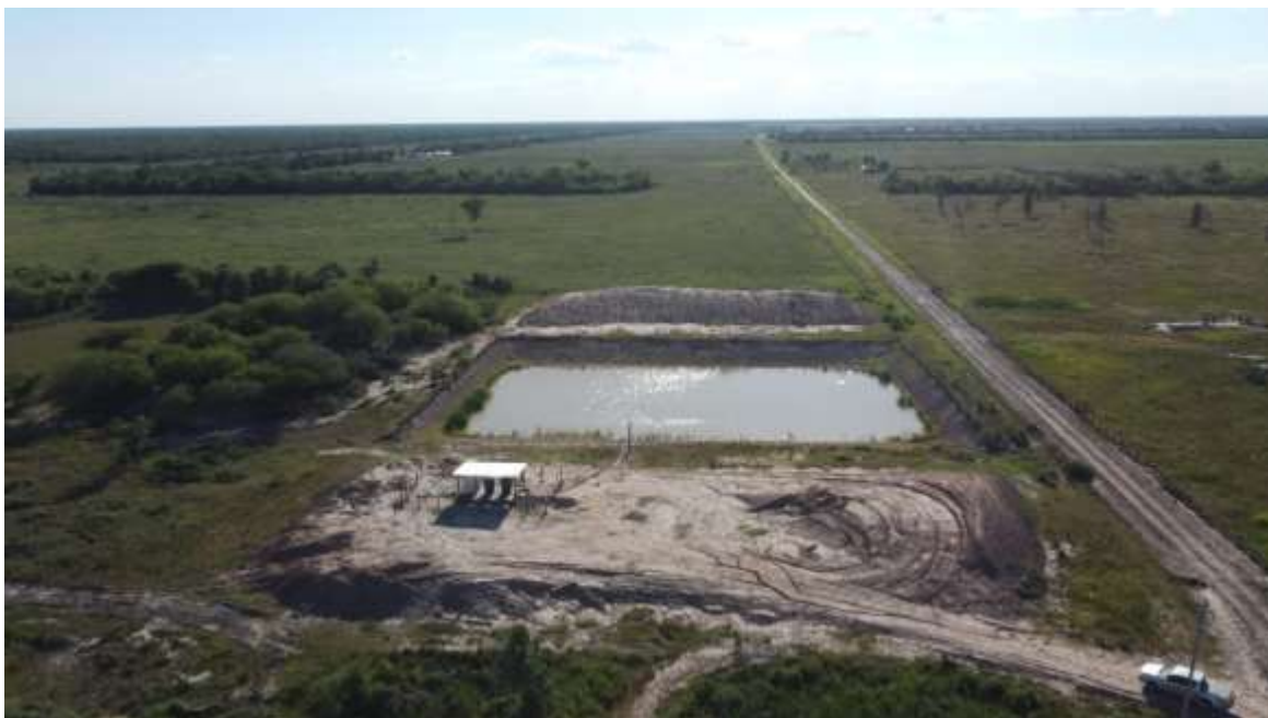
Figura 96 tajamar comunitario, construido con apoyo de COOPI y PCI.
