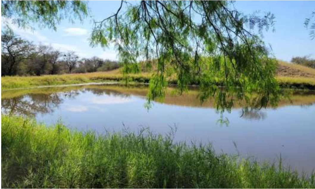
Figura 6. Tajamar SL 01, con agua, en buen estado
