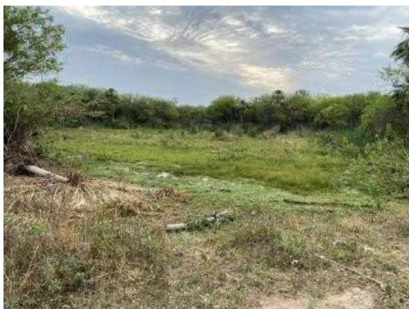
Figura 45. Tajamar viejo TP 05 colmatado
