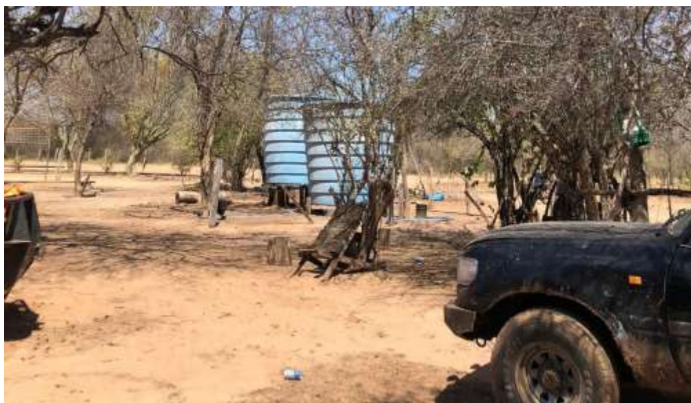
Figura 12. Tanques de la comunidad
