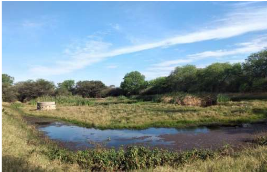
Figura 8. Tajamar SL 03 comunitario, con muy poca agua, casi seco
