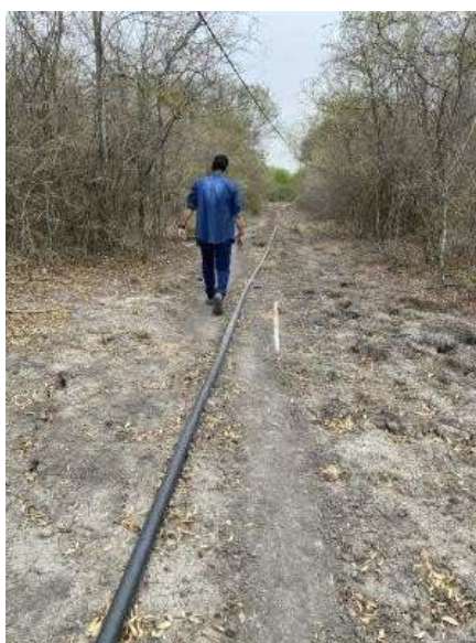
Figura 33. Tubería que conecta los tajamares SC 01 y SC 10
