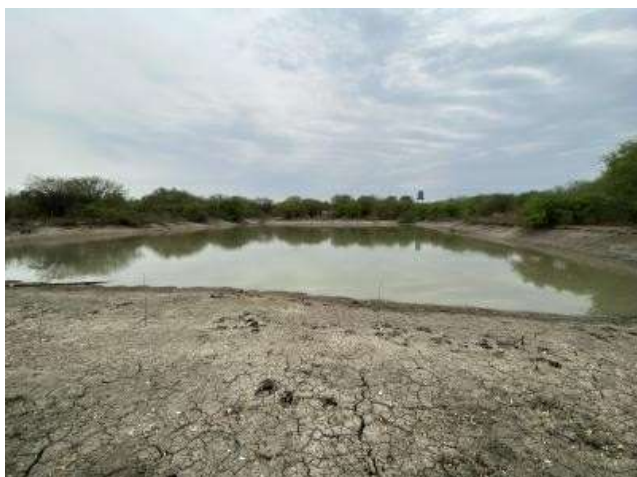
Figura 31. Tajamar SC 01, que bombea al tajamar SC 10
