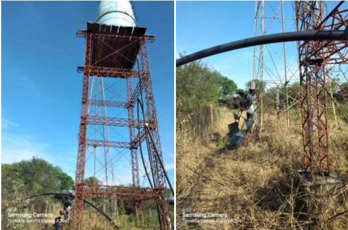
Figura 7. Tanques elevados del tajamar SL 03
