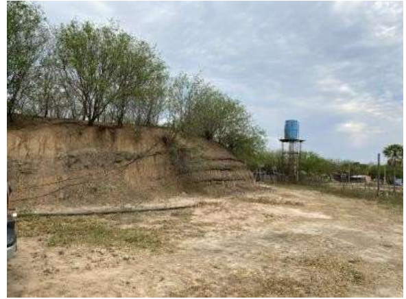
Figura 41. Tajamar TP 01 con el tanque elevado
