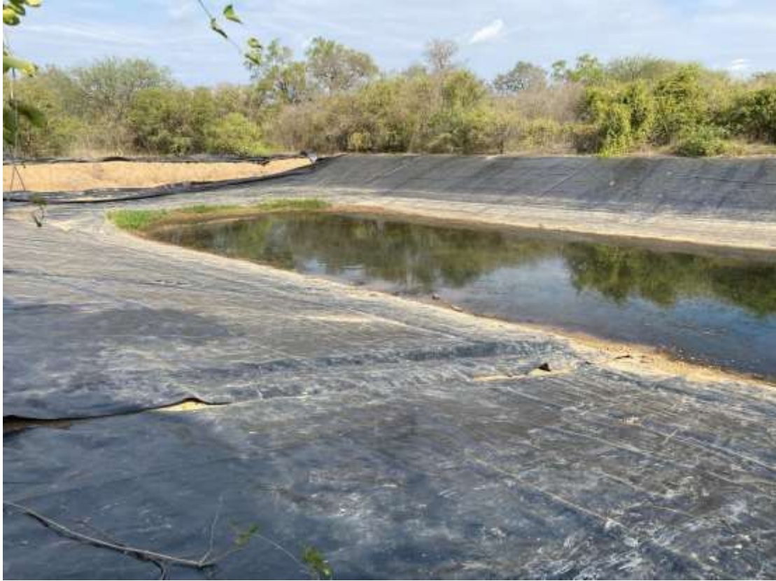
Figura 18. Tajamar CL 09, en San Pío X de 30 m x 60 m externos con 3 m de profundidad
