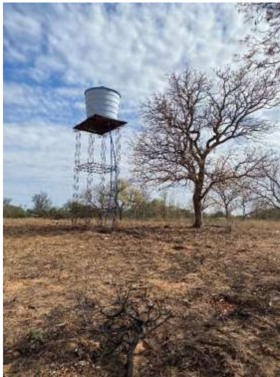
Figura 35. Tanque elevado en Jotoicha, agua de pozo somero
