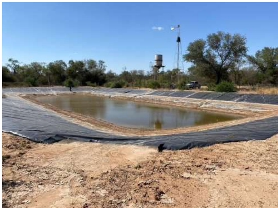
Figura 39. Tajamar CL 10 de 30 m x 60 m, con carpa, con molino de viento y tanque elevado
