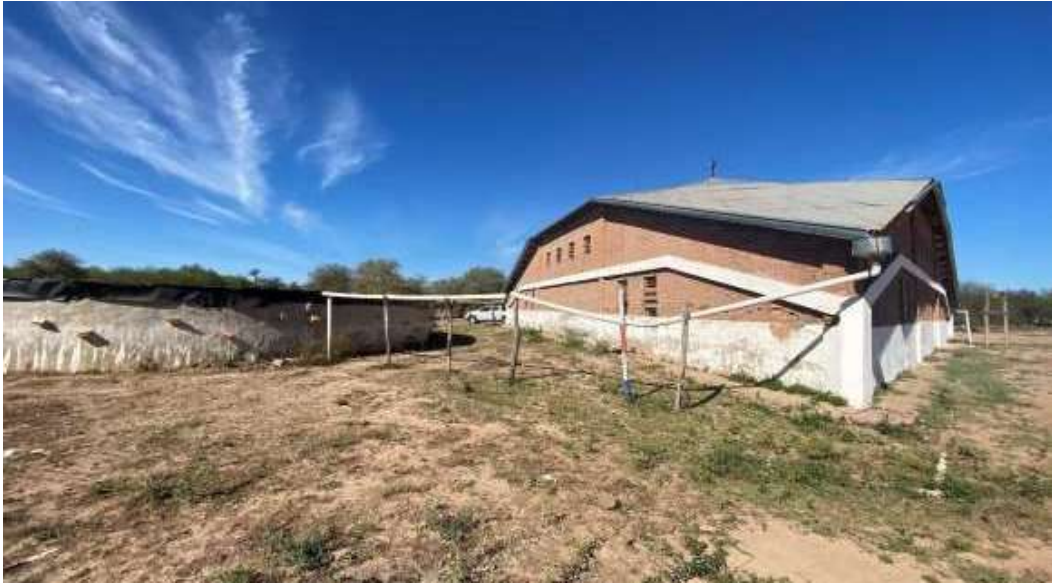
Figura 73. Techo de la iglesia para el tanque en General Díaz
