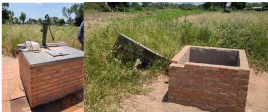
Figura 36. Aljibes en Santísima Trinidad (primero con agua, segundo no en enero 2022)
