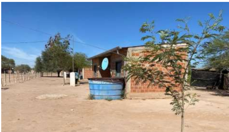
Figura 69. Tanque de una casa en la comunidad Cacique Sapo
