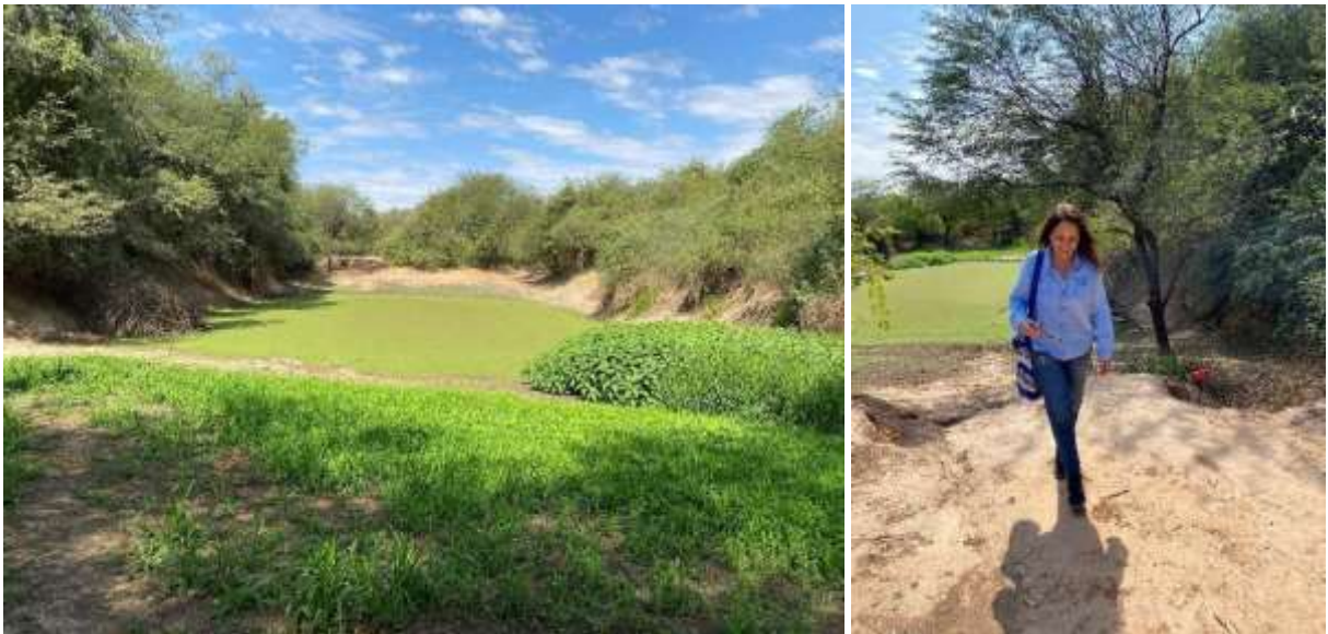
Figura 29. Tajamar CL 18, de 40 m x 100 m, visto desde los dos extremos
