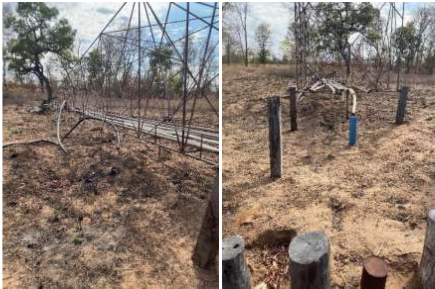
Figura 34. Molino de viento caído en Jotoicha
