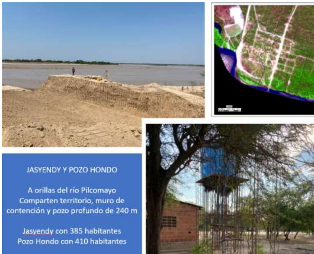
Figura 56. Infraestructura hídrica en Jasyendy y Pozo Hondo (datos enero y febrero 2022)
