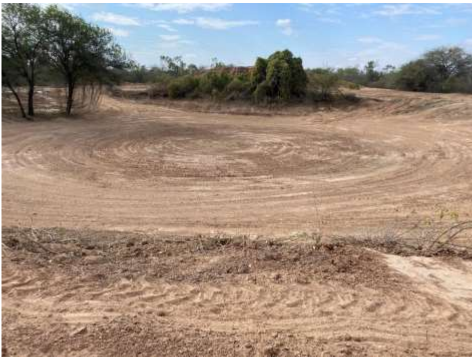
Figura 16. Tajamar CL 08 de San Pío X, redondo, con un diámetro de 50 m
