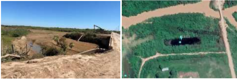
Figura 63. Excavación al costado del brazo del río Pilcomayo, CS 03
