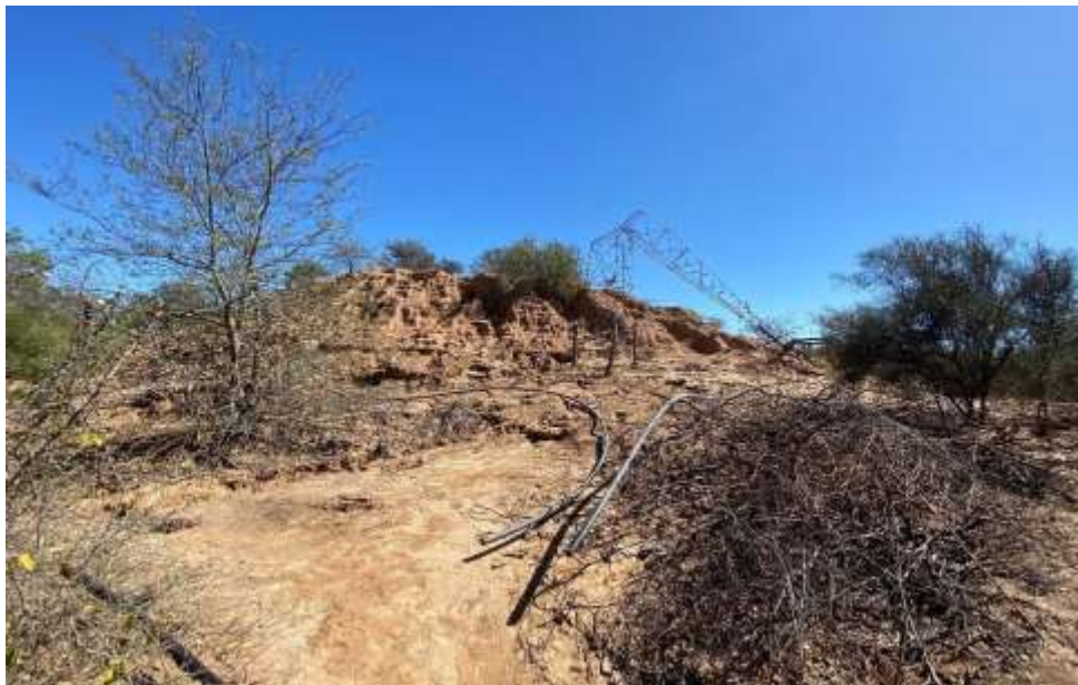
Figura 48. Estado de cañerías y molino viejo y caído del tajamar CL 12
