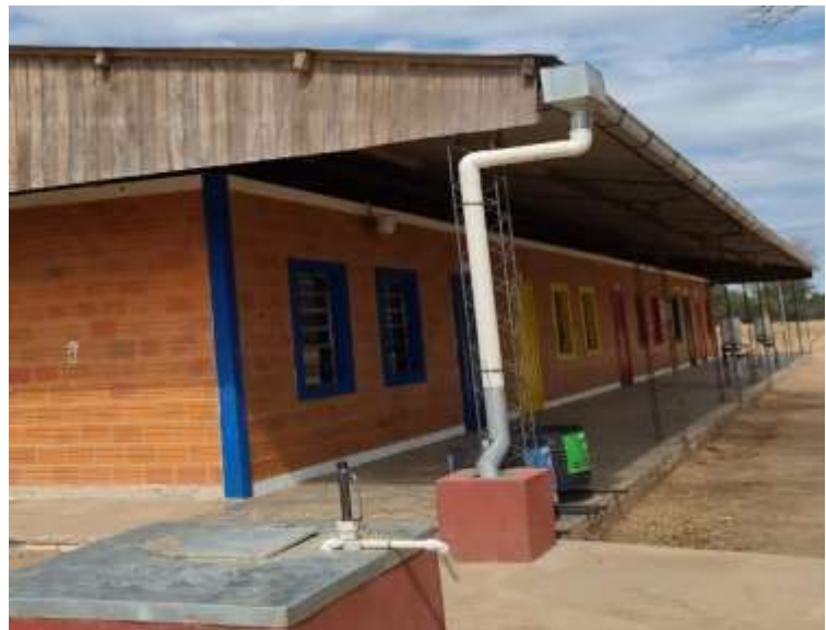
Figura 33. Sistema de recolección de agua de lluvia en la escuela
