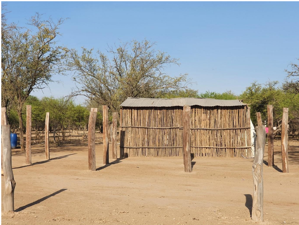
Figura 37. Vivienda en la comunidad de Yasyendi, en base a madera, con techo de chapa de zinc
