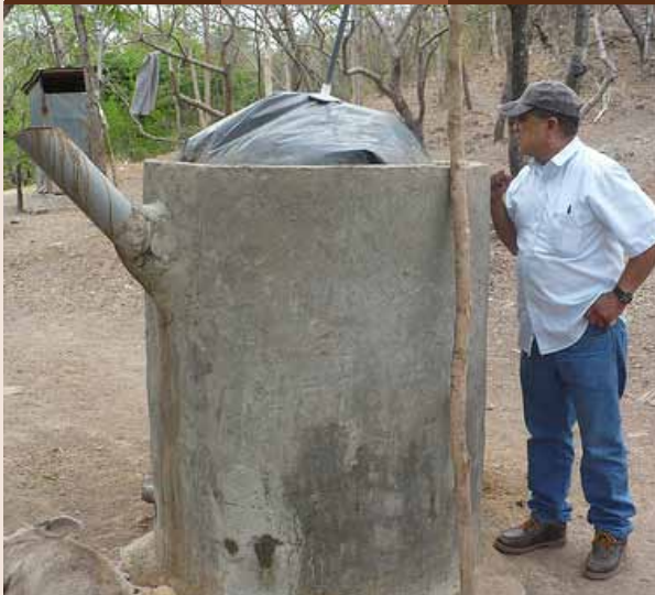
Biodigestores de pequeña escala.
