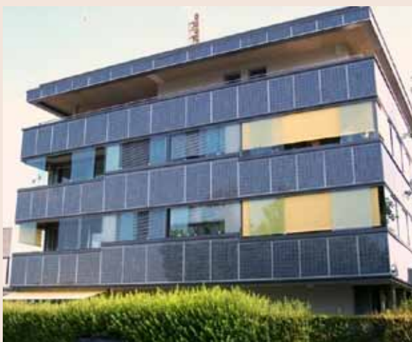
Edificio con paneles solares fotovoltaicos integrados en la fachada en Suiza.
