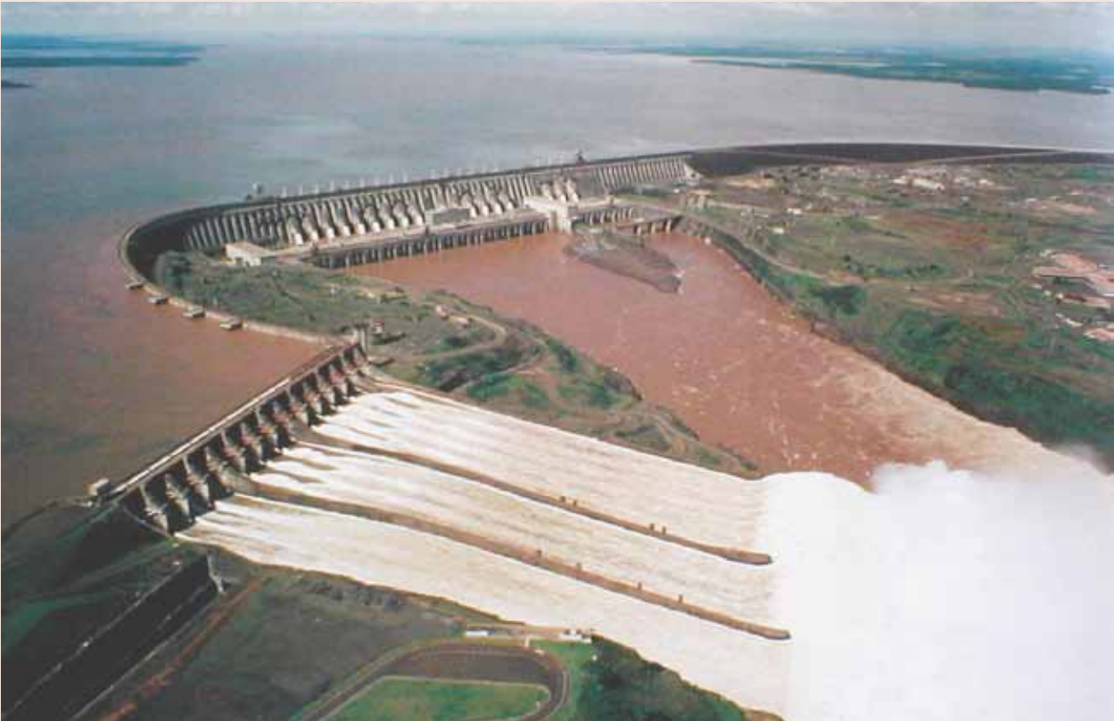
Represa Itaipú – 20 turbinas generadoras de 700 MW.
