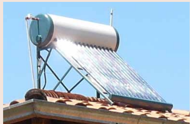
Calefón solar con colectores tubulares.
