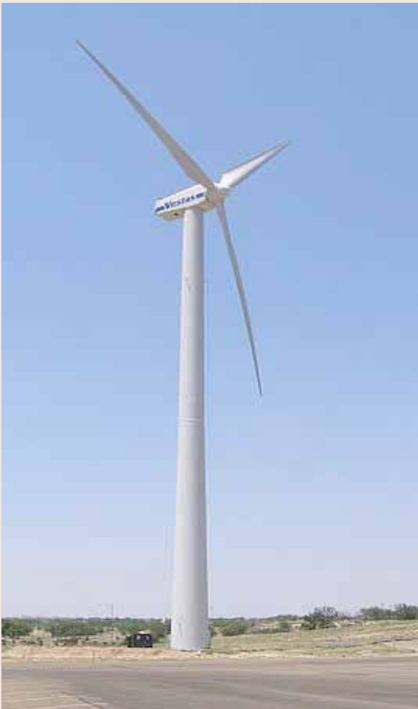
Aerogenerador para la producción de electricidad.
