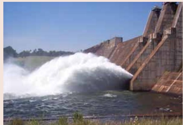
Represa Yguazú - Actualmente está en ejecución un proyecto de maquinización de la represa.
