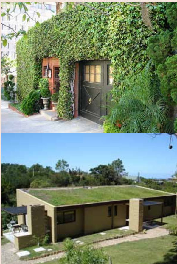
Techos y paneles verdes.
